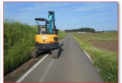
舗装浸食防止、崩落土除去！
