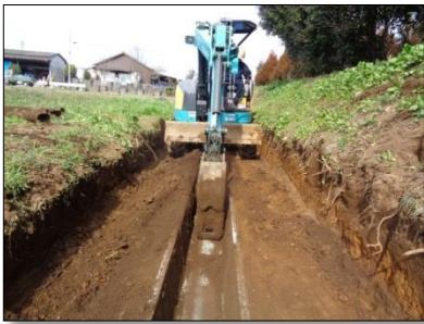
千経塚排水路の浚渫 約 60m
