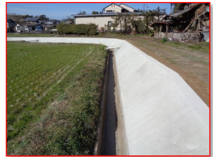
頭首工直下、法面からの崩落土は用水路末端まで支障を来します、水路管理と景観を考慮した張コン
