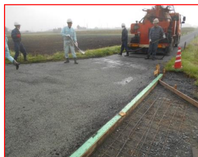
注視後、数日で危険な状態と成った幹線道陥没、舗装を外せば予想外の空洞有！ 即応の緊急工事
