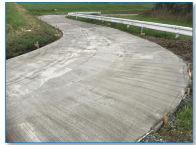
定原、凹断面生コン舗装 165m
