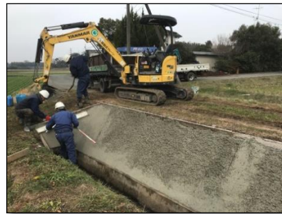
頭首工直下、法面からの崩落土は用水路末端まで支障を来します、水路管理と景観を考慮した張コン
