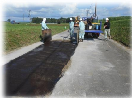
注視後、数日で危険な状態と成った幹線道陥没、舗装を外せば予想外の空洞有！ 即応の緊急工事
