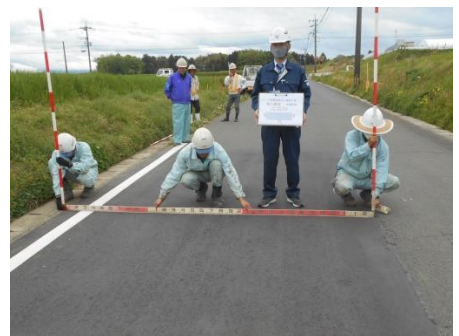
注視後、数日で危険な状態と成った幹線道陥没、舗装を外せば予想外の空洞有！ 即応の緊急工事
