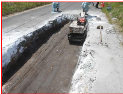
注視後、数日で危険な状態と成った幹線道陥没、舗装を外せば予想外の空洞有！ 即応の緊急工事
