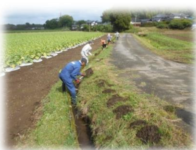
頭首工直下、法面からの崩落土は用水路末端まで支障を来します、水路管理と景観を考慮した張コン
