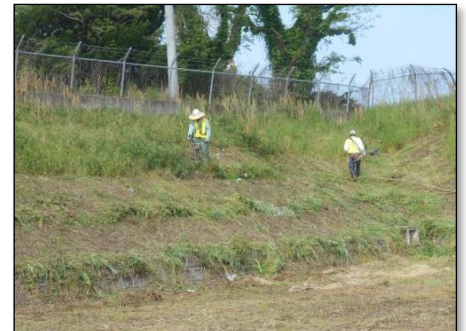
排水路末端、調整池
