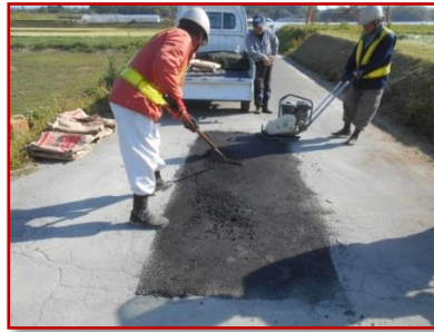
小影、常温合材による路面修復
