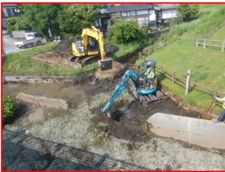
堤の水を全部抜き沈砂池の泥上げ
