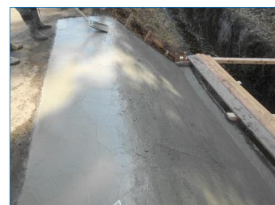
田久保境目線法面に導水壁を設置。農道の表面流水を排水路へ速やかに導きます
