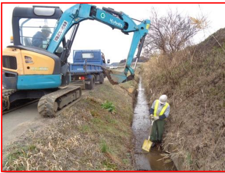
水路の泥上げ
