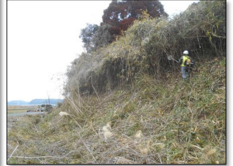
千経塚排水路法面
