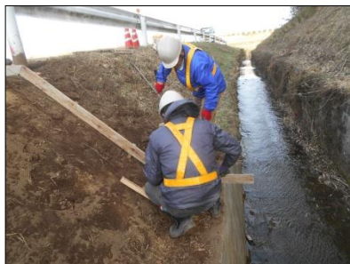
田久保境目線法面に導水壁を設置。農道の表面流水を排水路へ速やかに導きます
