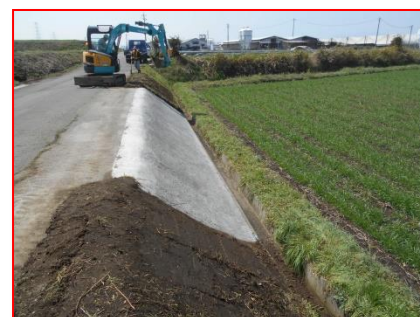
幹線1号の最北、栄上原地区の導水壁、路肩の損傷と滞水域が広く、法面強化の張コン工事？
