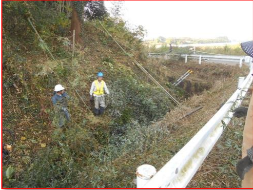
北部排水路法面の草刈り
