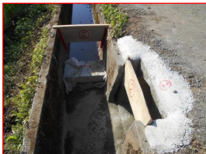
溢水吐(いっすいばき)大雨時用水路からあふれる不要水を排水路に落とし水田を守ります
