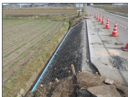
幹線1号の最北、栄上原地区の導水壁、路肩の損傷と滞水域が広く、法面強化の張コン工事？
