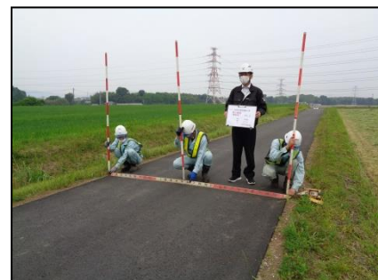
鹿毛の又線、約100m幅3m、アスファルト舗装工事を委託しました。写真は施工前と竣工検査
