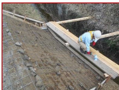
田久保境目線法面に導水壁を設置。農道の表面流水を排水路へ速やかに導きます
