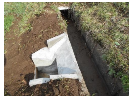
溢水吐(いっすいばき)大雨時用水路からあふれる不要水を排水路に落とし水田を守ります
