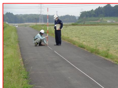
鹿毛の又線、約100m幅3m、アスファルト舗装工事を委託しました。写真は施工前と竣工検査
