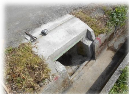
溢水吐(いっすいばき)大雨時用水路からあふれる不要水を排水路に落とし水田を守ります
