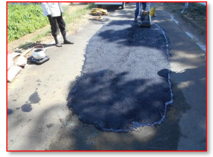
農道凹み補修
