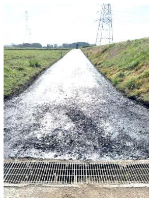
幅員 3m 総長 560m、細石で整地し油剤と砂「 3 回処理の防塵舗装 」通りの少ない農道にはコスト最高
