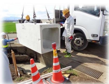
ゼロ勾配 30m最大深さ 80cm「 蓋無し排水路の改修 」メンテ用大型管渠と 300 パイプ 80mで滞水無し♪
