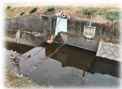
約 50 年働いてきた可動堰、幾度か薄いゴム板で対応して来た漏水も「 ヒンジゴムの全面張替 」で全止 !
