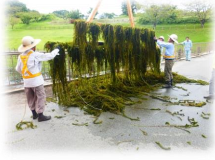
区からの要請、堤に繁茂していた水草 オオカナダモ 手作りの特製レーキをクレーンで引き回し除去
