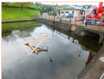
区からの要請、堤に繁茂していた水草 オオカナダモ 手作りの特製レーキをクレーンで引き回し除去
