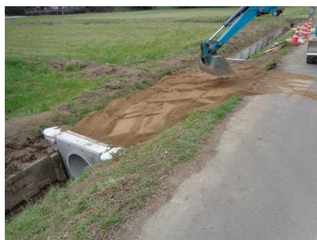
大型機械の渡れない狭くて脆弱な 進入路の更新工事 、安全安心、車両離合、そして耕作放棄防止、
