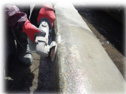
「堤下頭首工」暗渠への浮遊物流入防止の 溢水壁工事 、嵩上部を剥ぎモルタルで修正して研磨、通水
