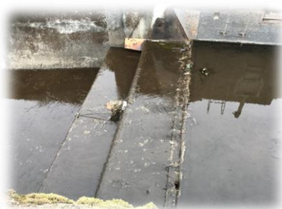
約 50 年働いてきた可動堰、幾度か薄いゴム板で対応して来た漏水も「 ヒンジゴムの全面張替 」で全止 !
