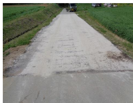
農道陥没 表層下に空間！下層に配管漏水、修理後山砂碎石で埋戻し、経過観察の要あり防塵舗装
