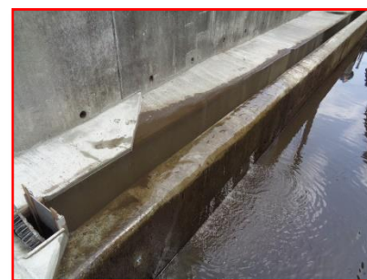
「堤下頭首工」暗渠への浮遊物流入防止の 溢水壁工事 、嵩上部を剥ぎモルタルで修正して研磨、通水
