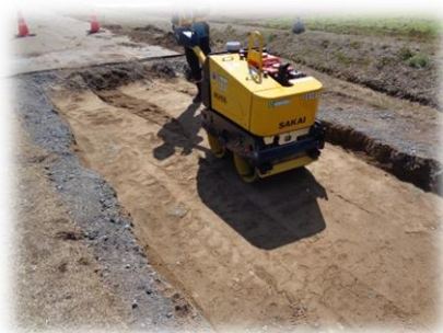
農道陥没 表層下に空間！下層に配管漏水、修理後山砂碎石で埋戻し、経過観察の要あり防塵舗装
