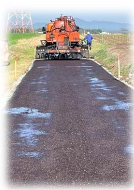
幅員 3m 総長 560m、細石で整地し油剤と砂「 3 回処理の防塵舗装 」通りの少ない農道にはコスト最高
