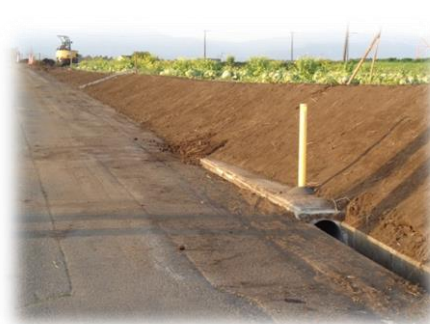
ゼロ勾配 30m最大深さ 80cm「 蓋無し排水路の改修 」メンテ用大型管渠と 300 パイプ 80mで滞水無し♪
