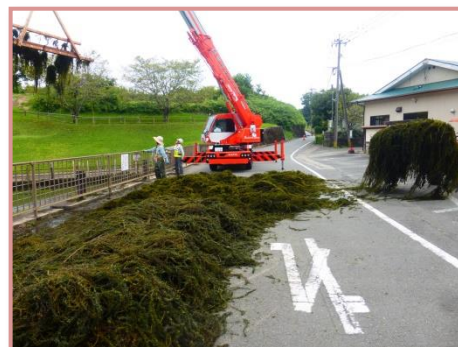
区からの要請、堤に繁茂していた水草 オオカナダモ 手作りの特製レーキをクレーンで引き回し除去
