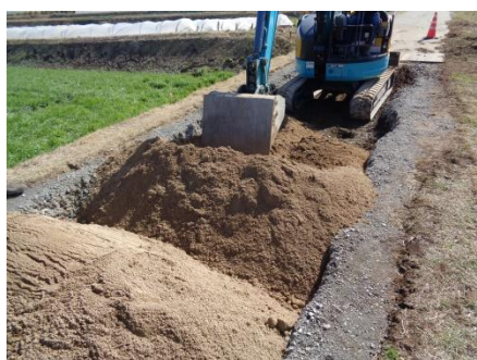
農道陥没 表層下に空間！下層に配管漏水、修理後山砂碎石で埋戻し、経過観察の要あり防塵舗装
