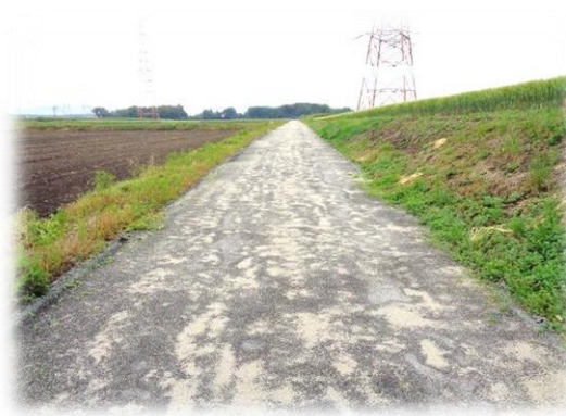
幅員 3m 総長 560m、細石で整地し油剤と砂「 3 回処理の防塵舗装 」通りの少ない農道にはコスト最高
