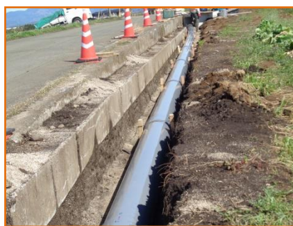
ゼロ勾配 30m最大深さ 80cm「 蓋無し排水路の改修 」メンテ用大型管渠と 300 パイプ 80mで滞水無し♪
